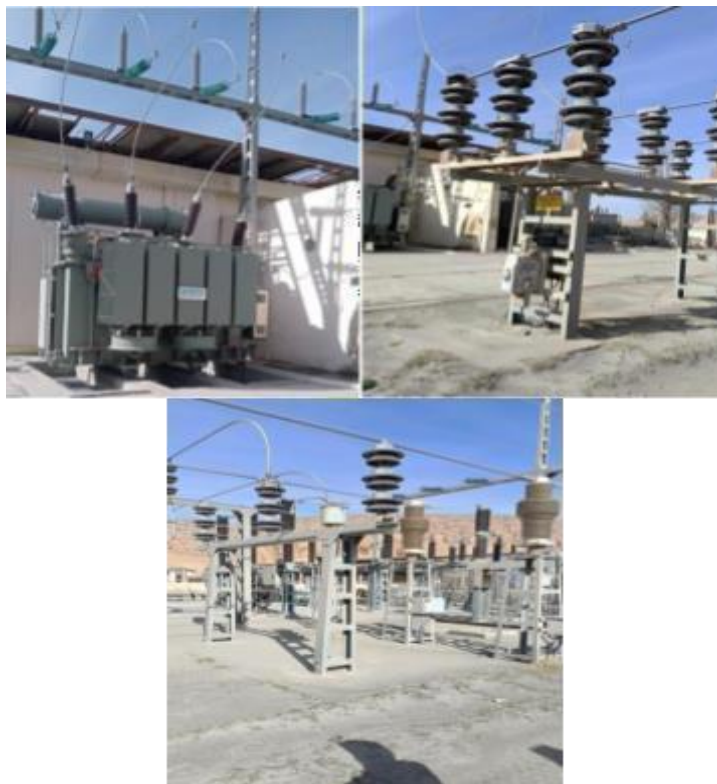
Figure I.4: la composition du poste 90/5.5 KV
