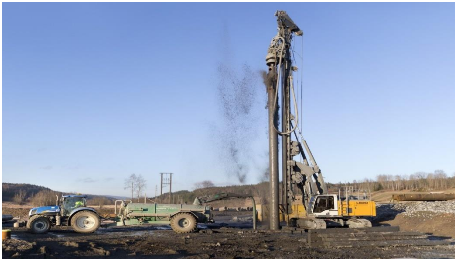
Figure 2.1. Forage au marteau fond de trou [8]
