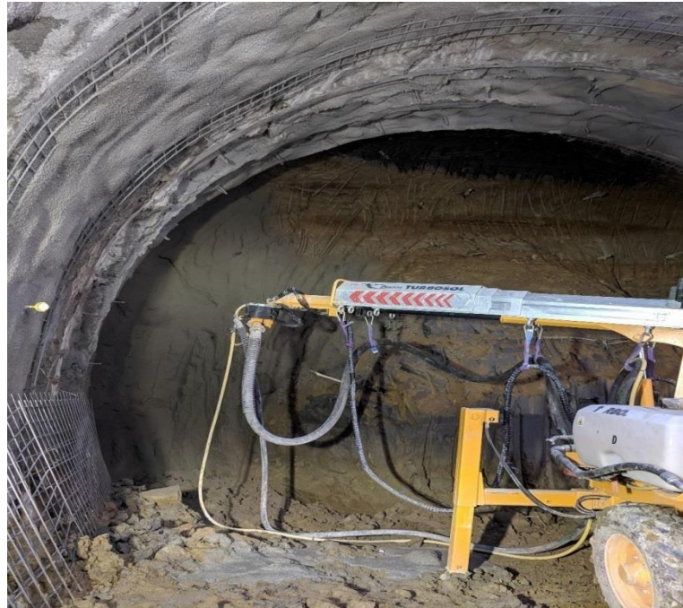
Fig. II.13 L'injection de béton projeté [49].
