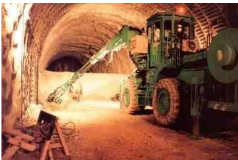
Fig.II.06 Creusement du tunnel en demi-section [20].
