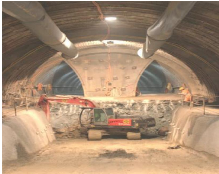
Fig II.07 Creusement du tunnel en section divisée. [22]
