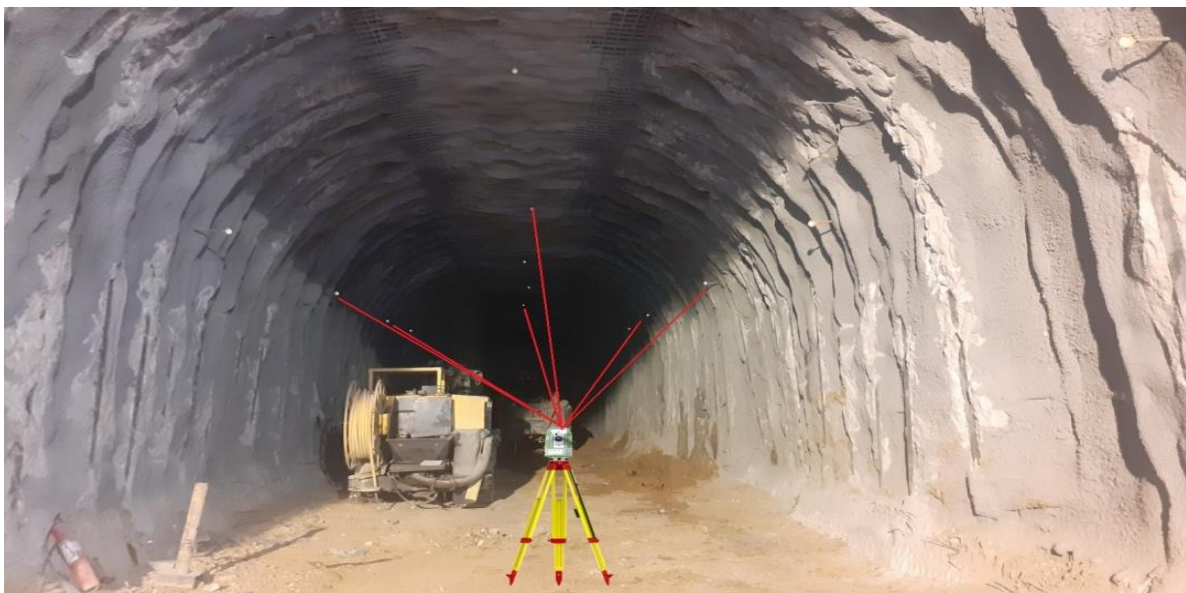
Fig.III.10 procédure d'auscultation des cibles bi-flex
