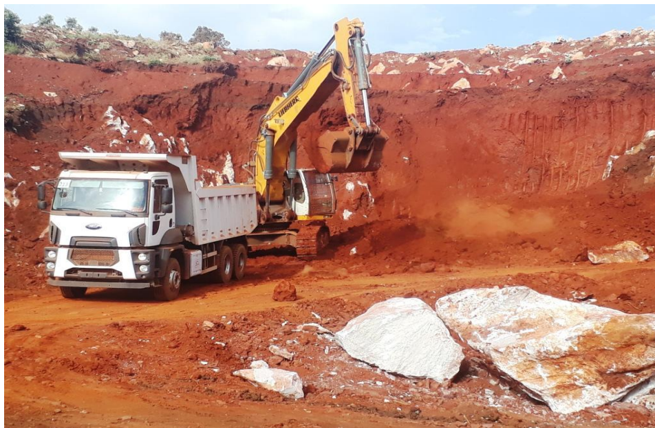
Fig.II.8 : Opération de chargement et transport
