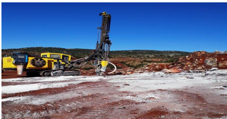
Fig.II.7 : Travaux de forage
