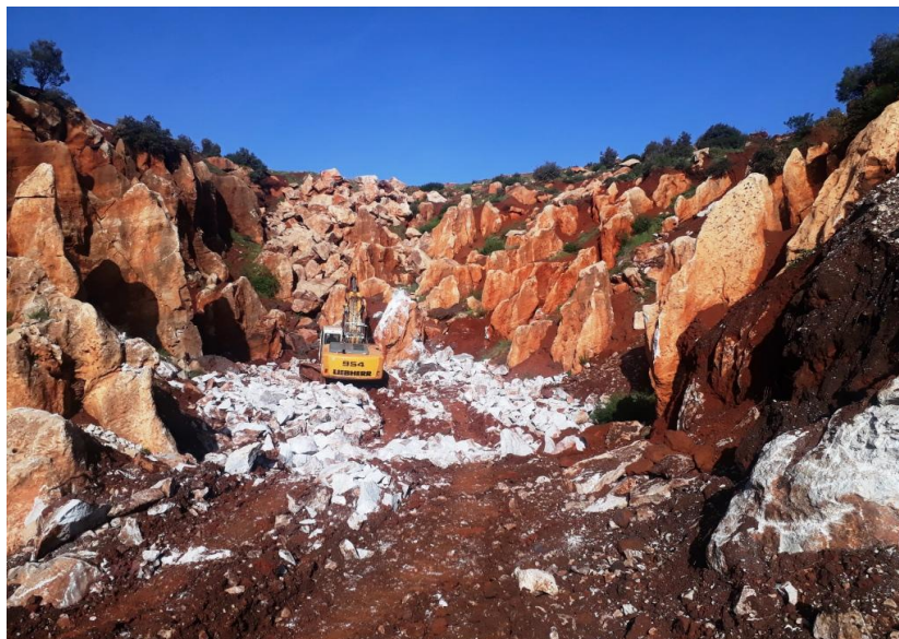
Fig.II.6 : abattage mécanique avec brise roche.
