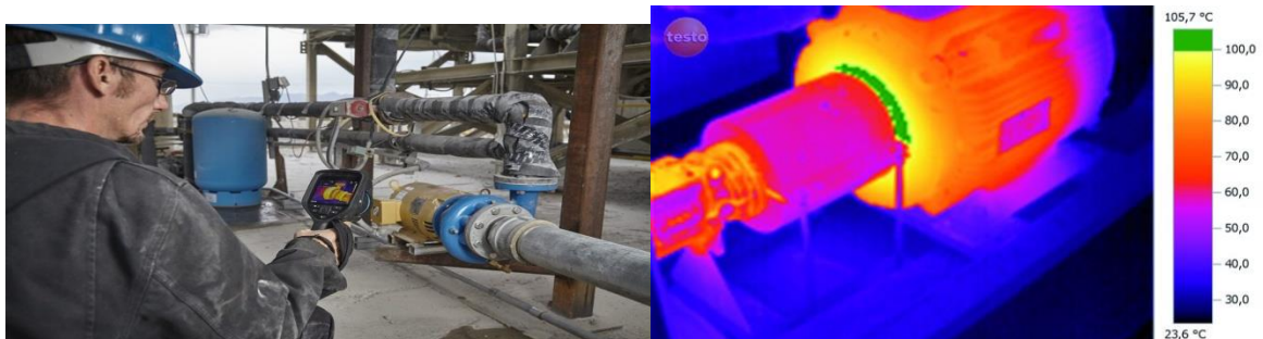
Figure 6 – Contrôle des machines tournantes par l'analyse thermographie infrarouge
