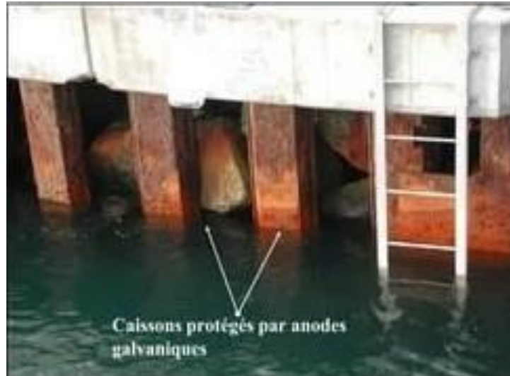
Figure 4-2 : Rideaux de palplanche protégés par anode sacrificielle
