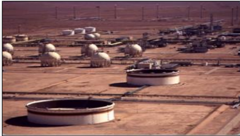
Figure I.2: les réservoirs sphériques et cylindriques.
