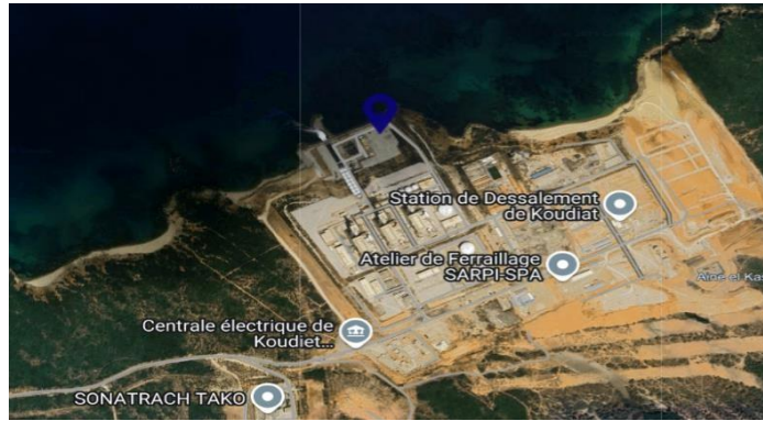
Figure I.2 : La situation géographique de la centrale électrique [4]
