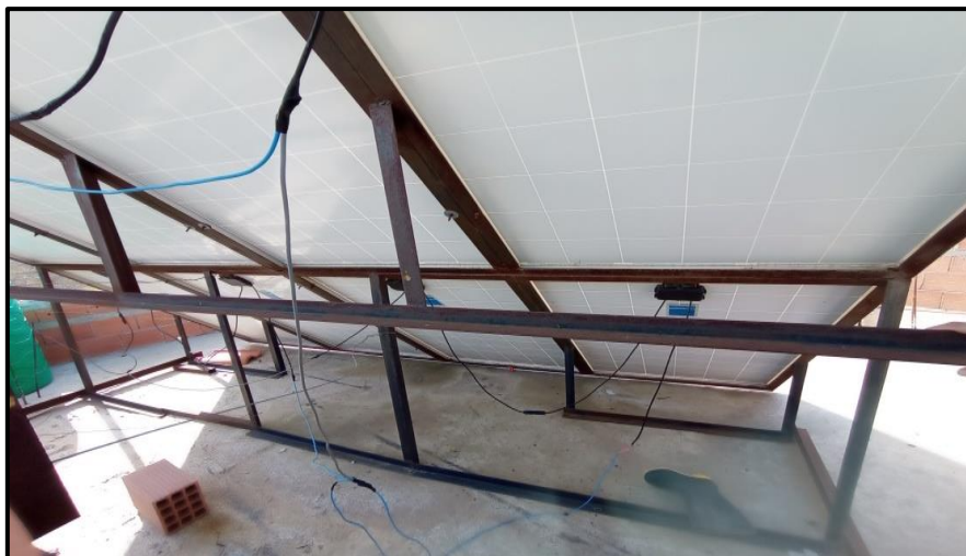
Figure IV.10: La connexion de les 8 panneaux
