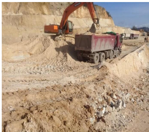
Figure II.2: L'exploitation dans le corps central
