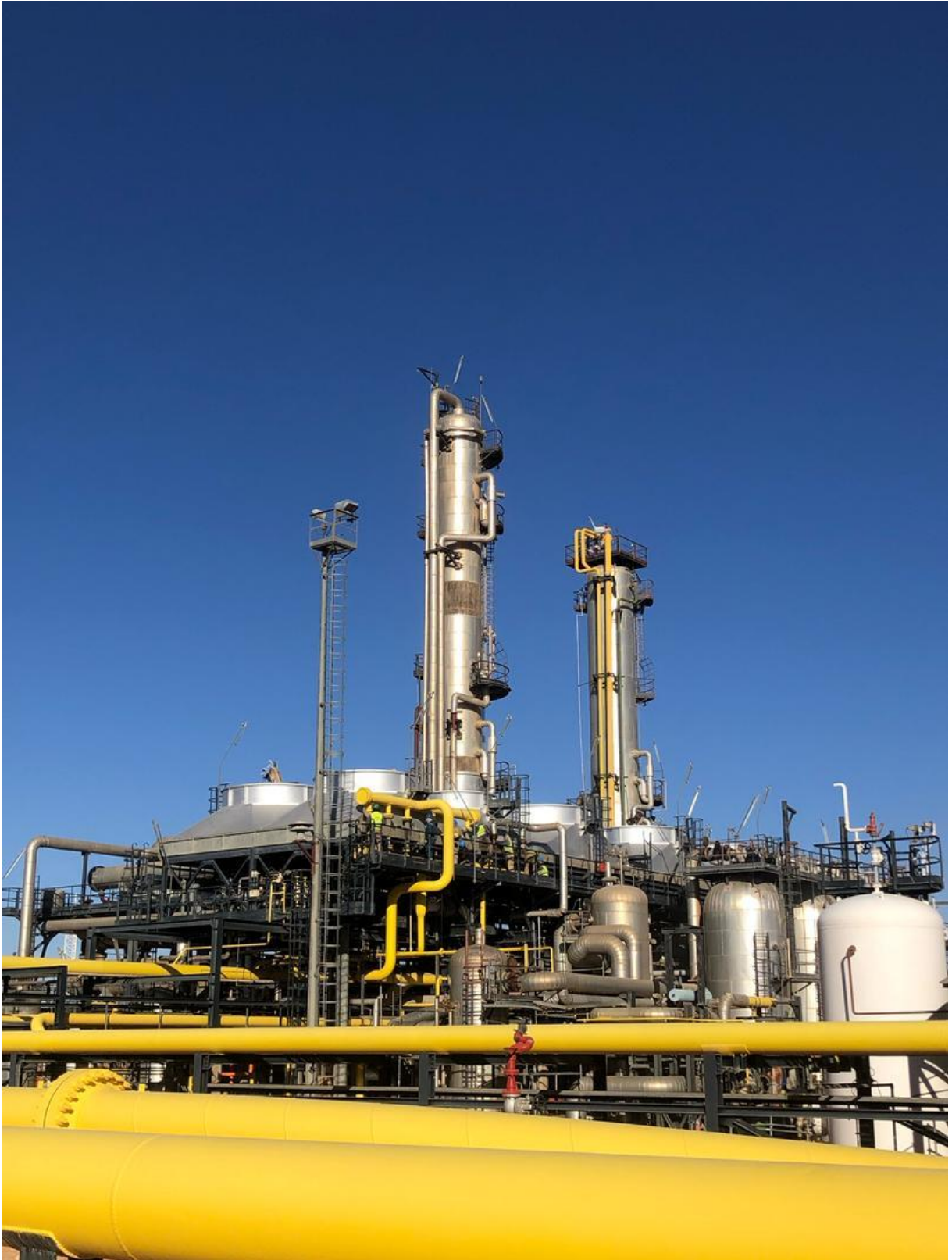
Figure 07 : Déthaniseure et débutaniseur
