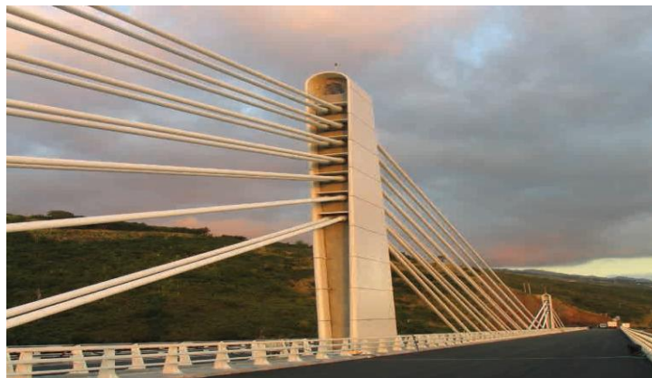
Figure I.23. Viaduc des trois bassins à La Réunion
