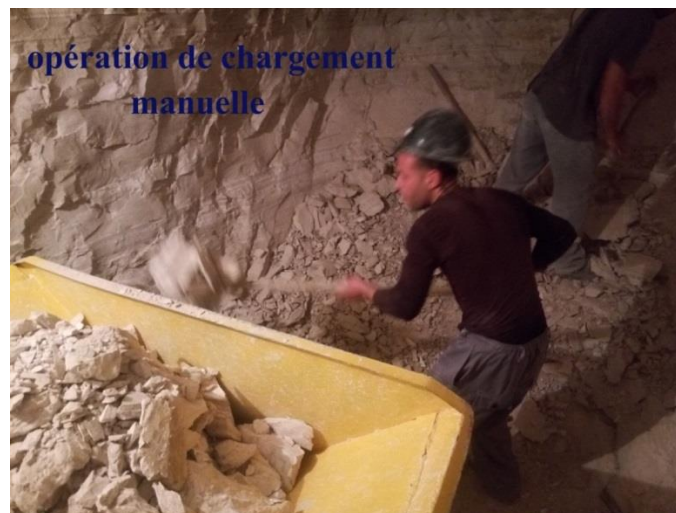
Figure III.11 : Opération de chargement manuel dans les wagonnets.
