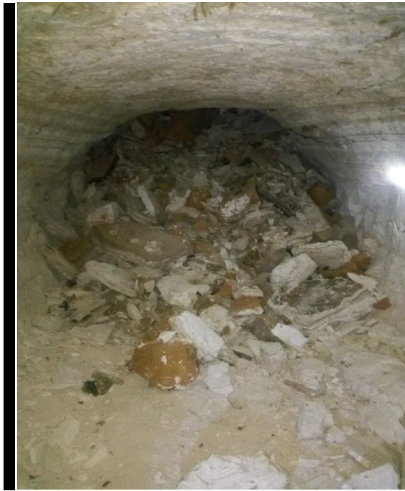
Figure III.8: Opération de foudroyage
