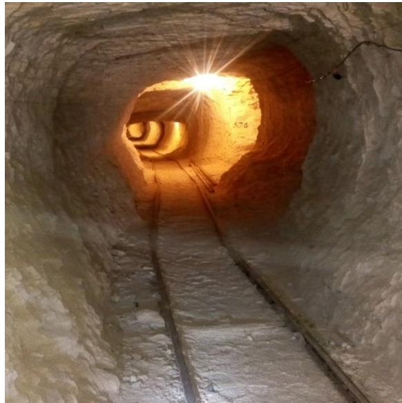
Figure III.6: Entrée de la galerie principale.
