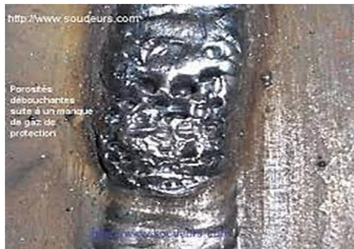
Figure II.14.Porosités débouchâtes en surface de cordon de soudure
