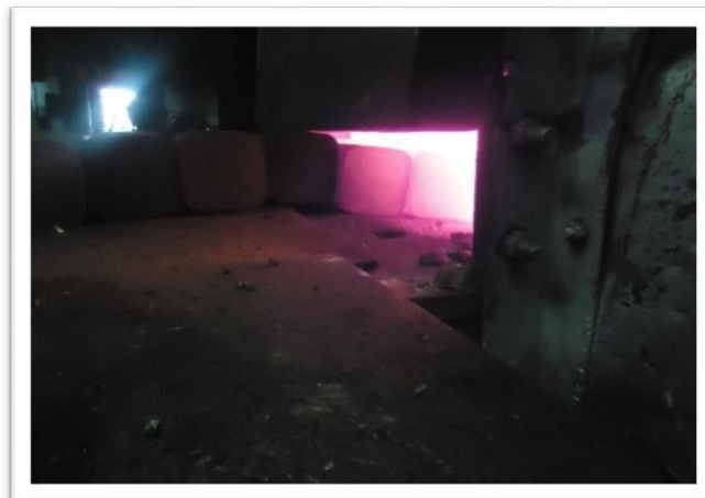
Figure.III.4 : Four du chauffage.
