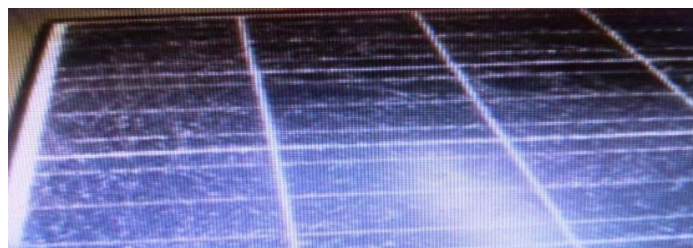
Figure II.4: Dégradation du module photovoltaïque par des bris de verre [9]
