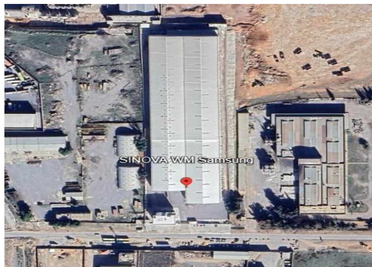
Fig I. 2 : Site machines à laver
