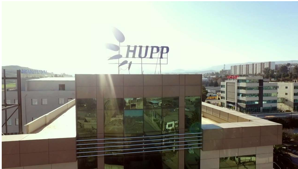
Figure 1.a-2 Hupp pharma vue de l'extérieure
