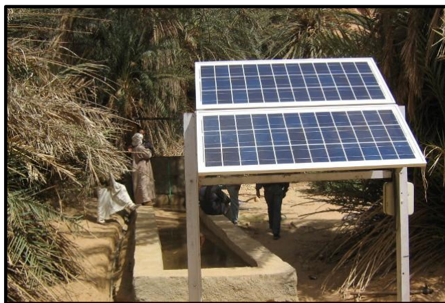
Figure 1.14 Pompage solaire photovoltaïque au sud algérien
