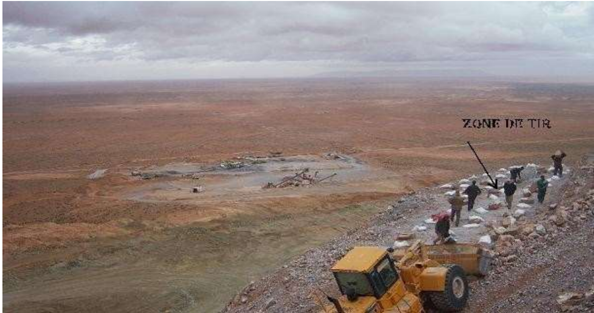
Figure III.4 : Volée de tir (Z = 910 m). [Sur site]
